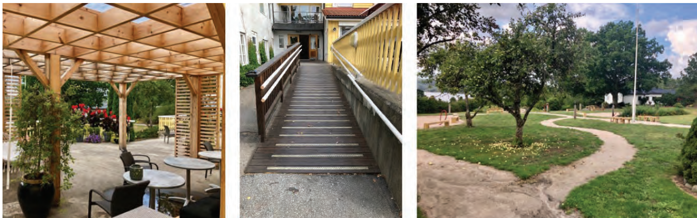
Figur 5: Pergola som ble bygget for å tilby skyggeplasser, trerampe med antiskli og rekkverk samt ganger som ble laget og er omgitt av sittemøbler.
